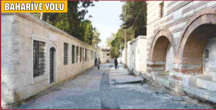
Kırkmerdiven Caddesi'nin altyapısı tamamlanan kısmında taş döşeme işlemi gerçekleştiriliyor.
