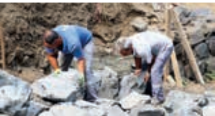
Fen İşleri Müdürlüğü ekipleri ihtiyaç duyulan noktalarda perde ve taş duvarlar yapıyor.
