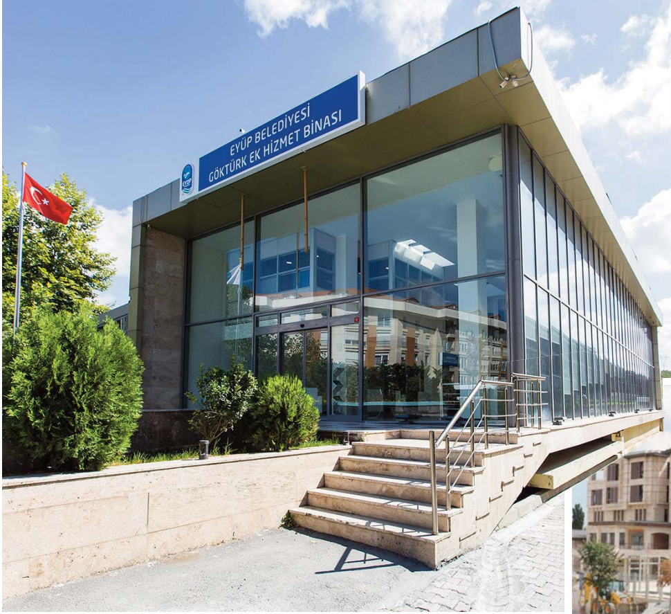
Göktürklüler için yapılan yeni Belediye Ek Hizmet Binası faaliyete geçti. Eski Belediye Hizmet Binası ise Kültür Merkezi olarak Ekim ayından itibaren hizmete giriyor.
